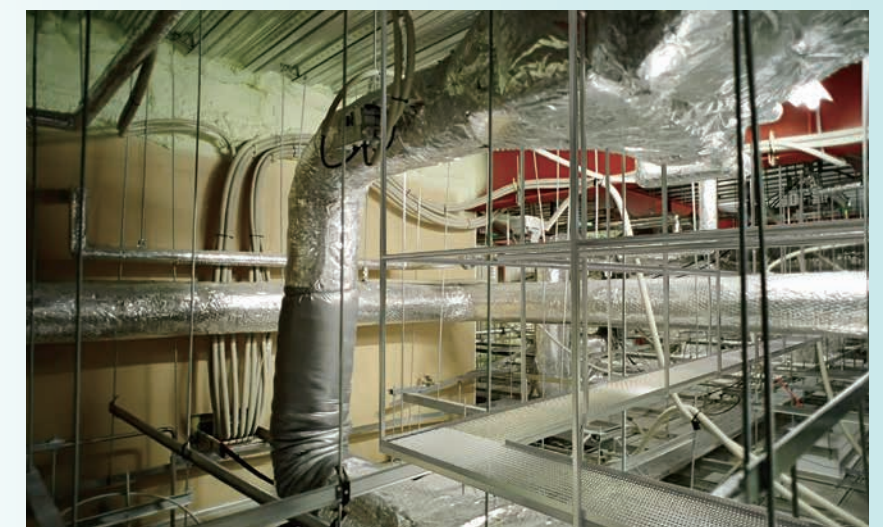
在来工法(LGS工法) [軽量天井下地、石膏ボード、化粧ケイカル]
